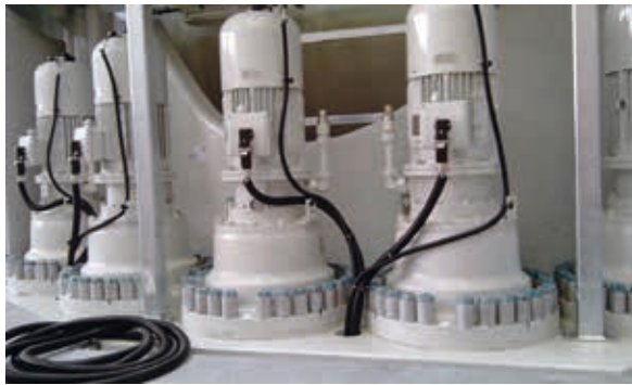
Abb. 60: Über Steckverbinder angeschlossene Motoren, die den Rotor einer Windenergieanlage dem Wind nachführen – Quelle: Harting
