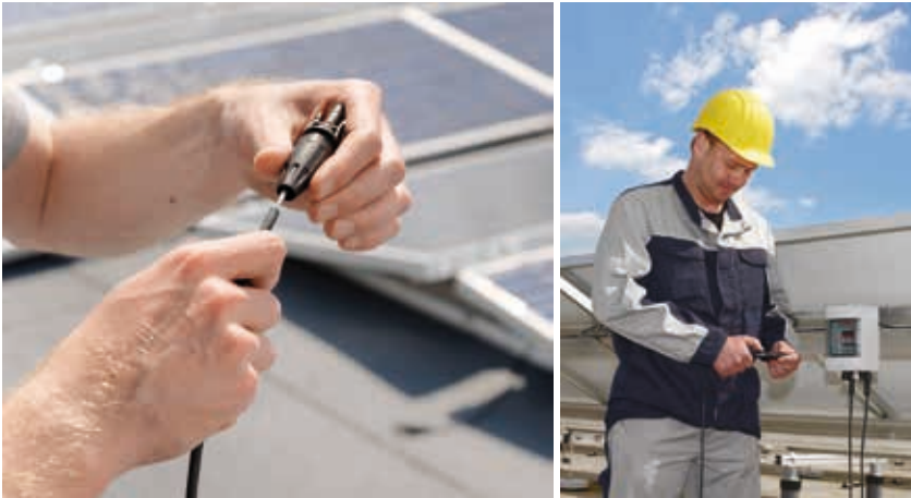
Abb. 62 und 63: Feldkonfektionierbare Push-in-Steckverbinder an einer PV-Anlage Abb. links: Quelle: Weidmüller, Abb. rechts: Quelle: Phoenix Contact
