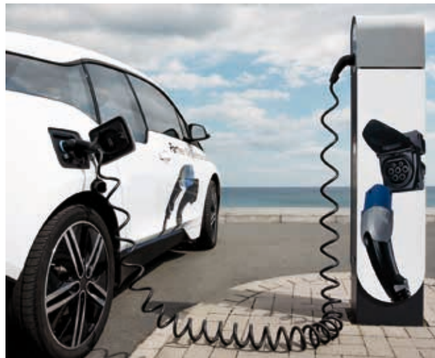
Abb. 94: Ladestation für Elektroauto – Quelle: Harting
