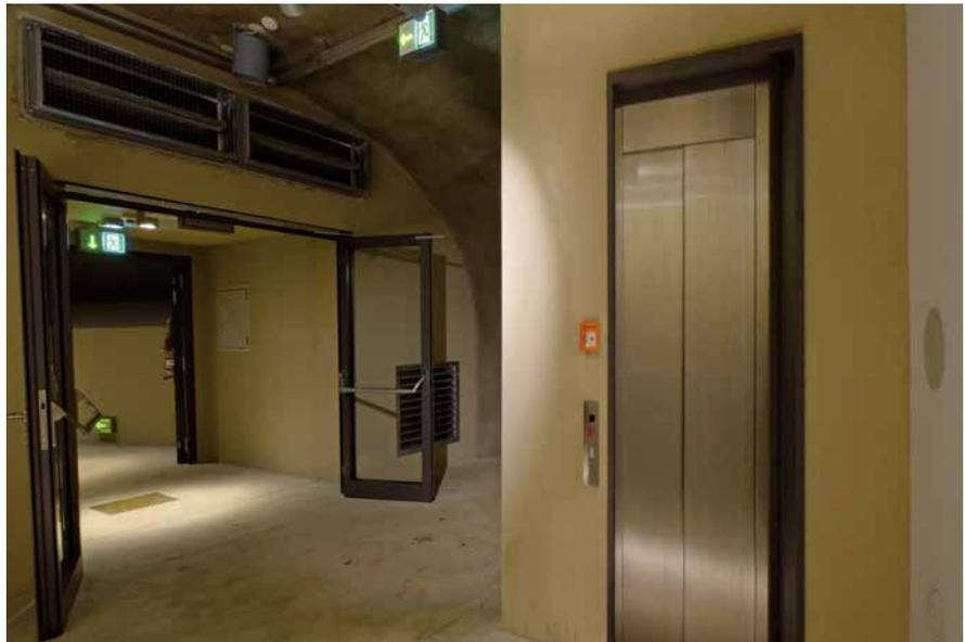
Bild 21: Aufzugsvorraum mit einer Schleuse
