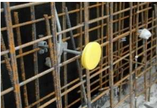
Abbildung 34: Einbau eines Erdungsfestpunktes in einer Kellerwand eines Wohngebäudes, Quelle Dehn
