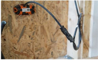
Abbildung 32: Rückseitige Ansicht einer Installationseinheit in Verbindung mit Installationssteckverbindern, Quelle Wieland Electric GmbH
