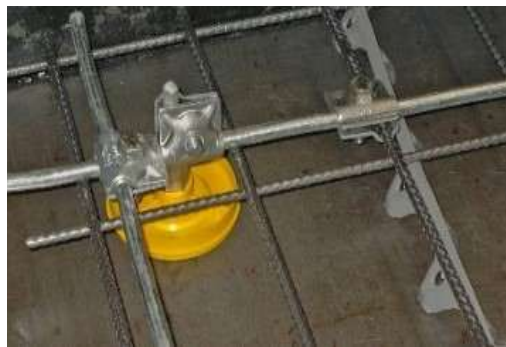
Abbildung 35: Einbau eines Erdungsfestpunktes in eine vorgefertigte Modulwand SE Quelle Dehn SE
