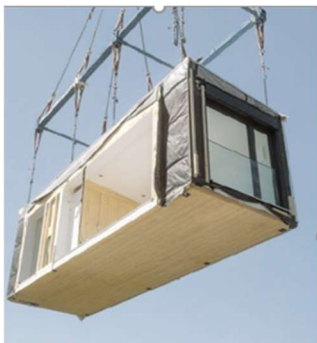
Abbildung 28: Vorgefertigtes Baumodul, Quelle Wieland Electric GmbH
