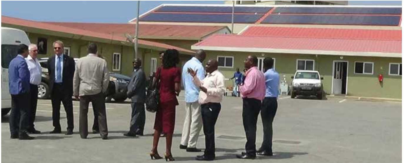
Die netzgekoppelte PV-Anlage an der Luanda International School wurde am 10. Dezember 2014 feierlich eröffnet. – The grid-connected PV system at Luanda International School was officially opened on 10 December 2014.
