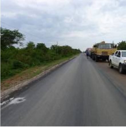
Erneuerung von Straßenabschnitten zwischen Bujumbura und Gitega, © Maurice Bugabekazi
