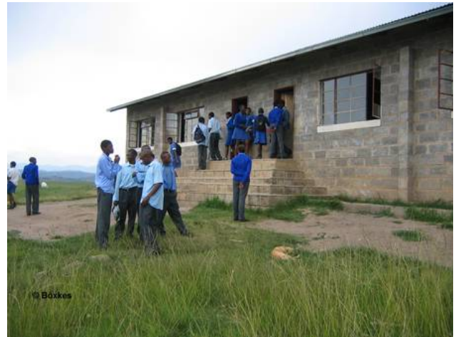
Grundschule in der ländlichen Umgebung von Leribe. In dem Gebäude befinden sich die beiden Klassenzimmer. (Photo Böxkes)
