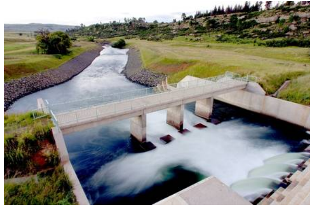
Ashriver Outfal. Photo: Ministry of Energy and Water. Mit freundlicher Genehmigung der lesothischen Botschaft in Berlin.
