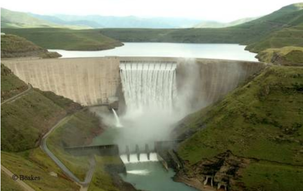
Katse Staudamm. Photo: Böxkes
