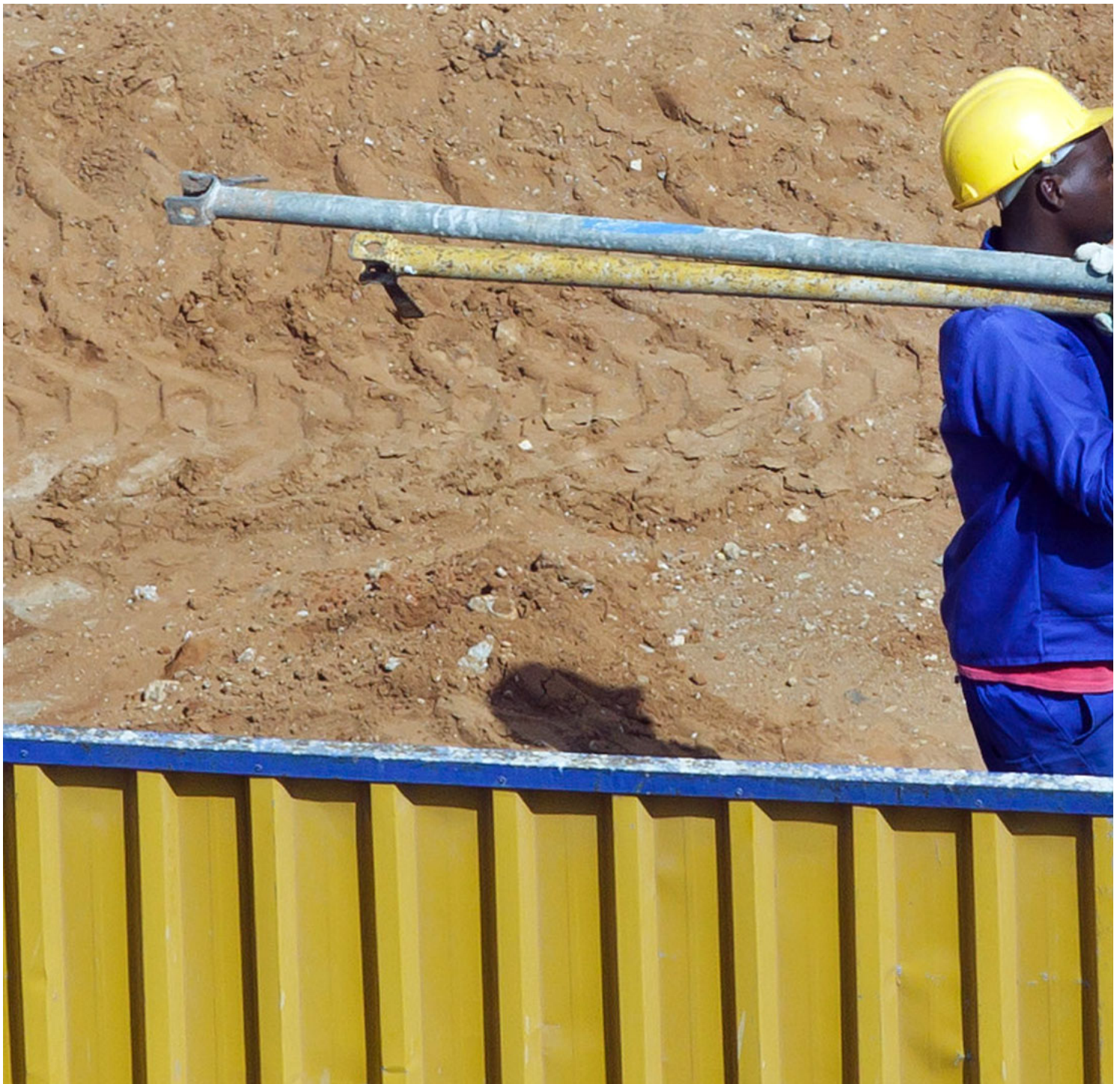
Ein Bauarbeiter trägt Stahlrohre über eine Baustelle in Mosambiks Hauptstadt Maputo. Urheberrecht© Thomas Trutschel/photothek.net
