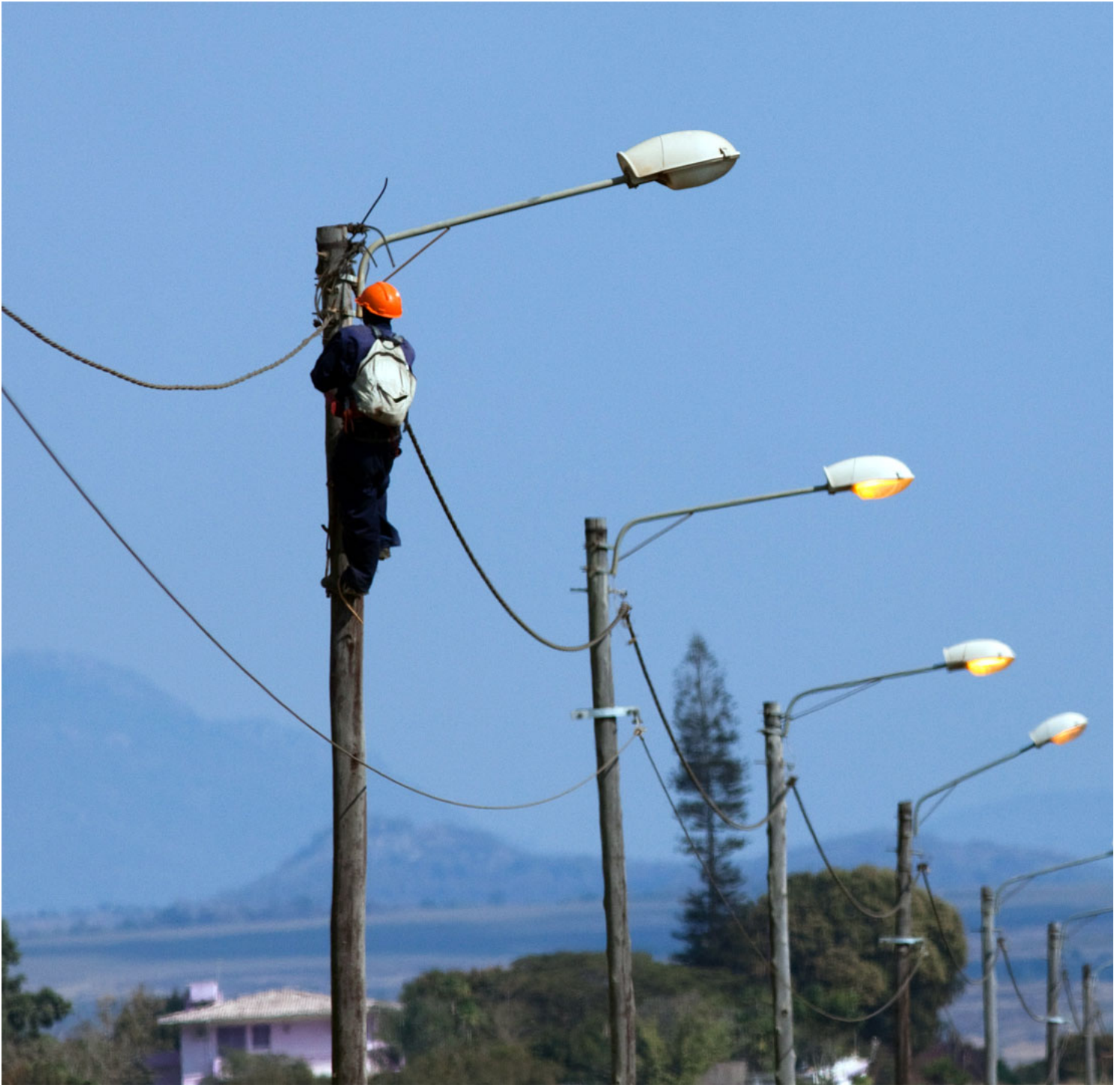
Ein Techniker repariert die Straßenbeleuchtung in Chimoio, Mosambik Urheberrecht© Ute Grabowsky/photothek.net
