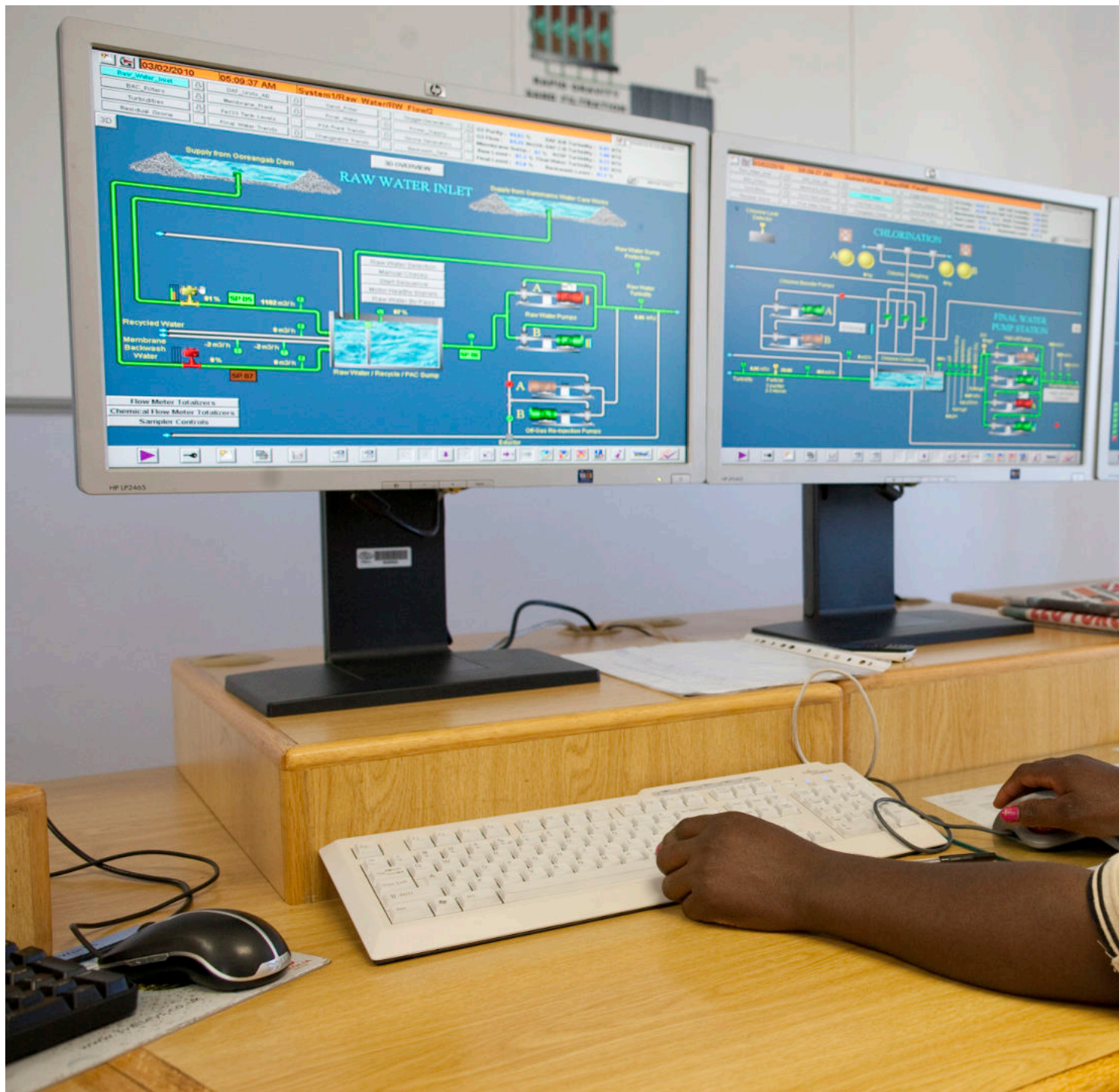
Wasseraufbereitungsanlage Goreangab in Windhuk, Namibia Urheberrecht© Thomas Imo/photothek.net
