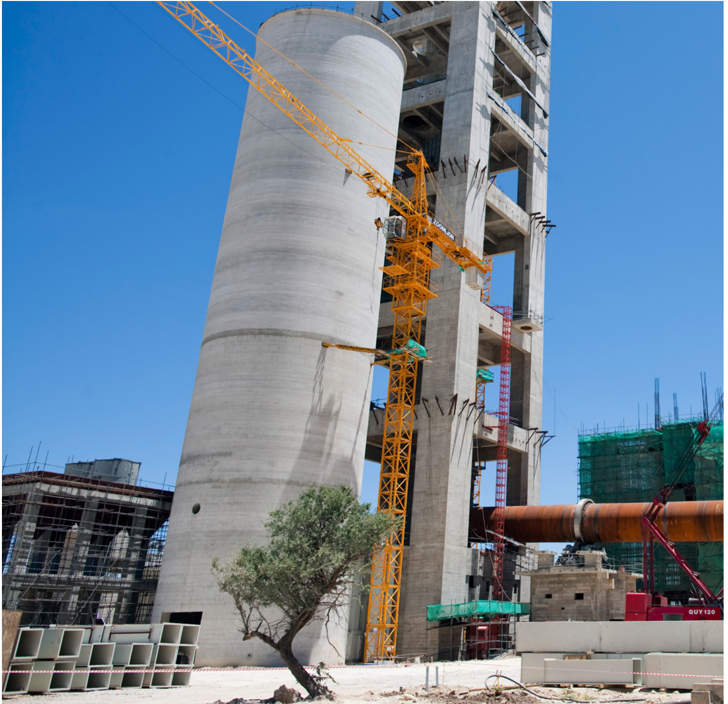
Baustelle der Ohorongo-Zementfabrik in Otavi, Namibia. Das Zementwerk ist die größte deutsche Direktinvestition in Namibia. Urheberrecht© Thomas Imo/photothek
