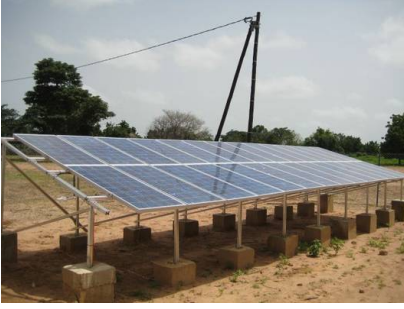
Solarpanels auf dem Land © Peracod/GIZ
