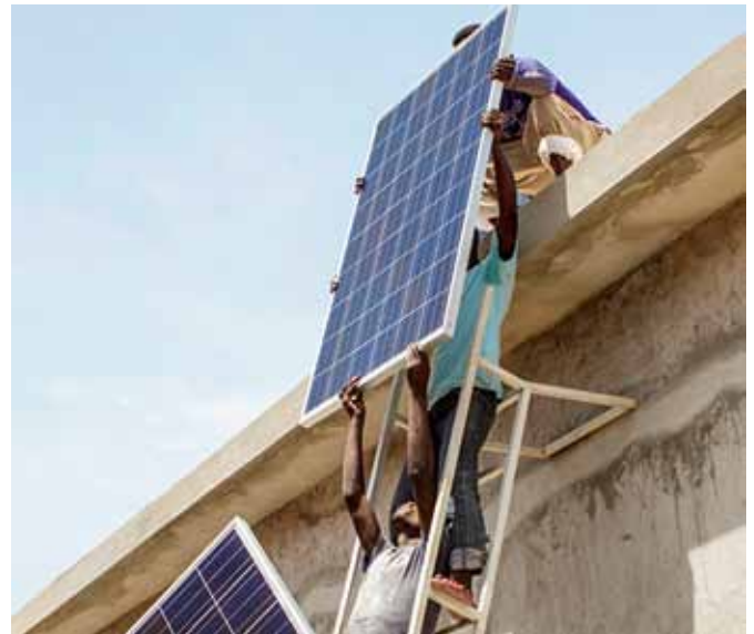
Innerhalb von sechs Tagen errichteten Ingenieure der deea die Anlage in Zusammenarbeit mit Arbeitern aus der Region – In collaboration with regional workers, the deea engineers installed the PV system in only six days
